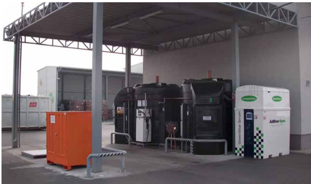
Čerpací stanice pohonných hmot v Chrášťanech u Prahy
